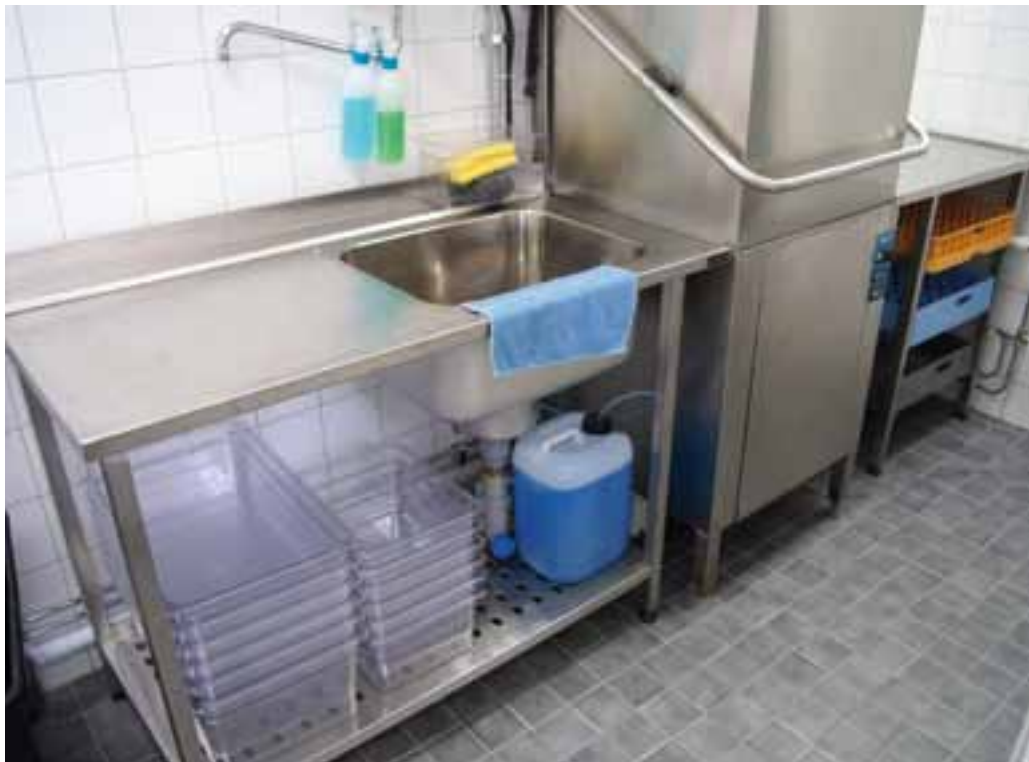
In och utmatningsbänk dockad mot en Wexiö WD 6 diskmaskin.
