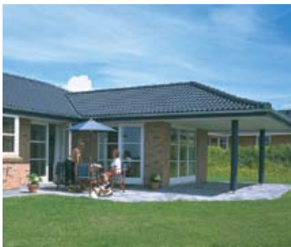
Overdækket terrasse i forlængelse af vinkelbygning.
