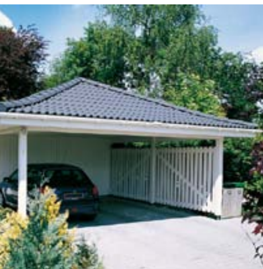
Fritliggende carport i husets arkitektur
