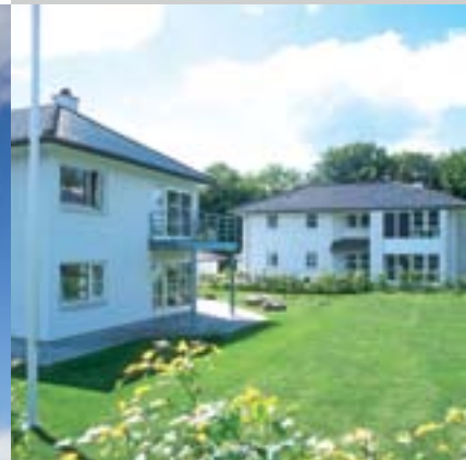
Eksempel på 2 plans palævilla opført i moderne byggestil.
