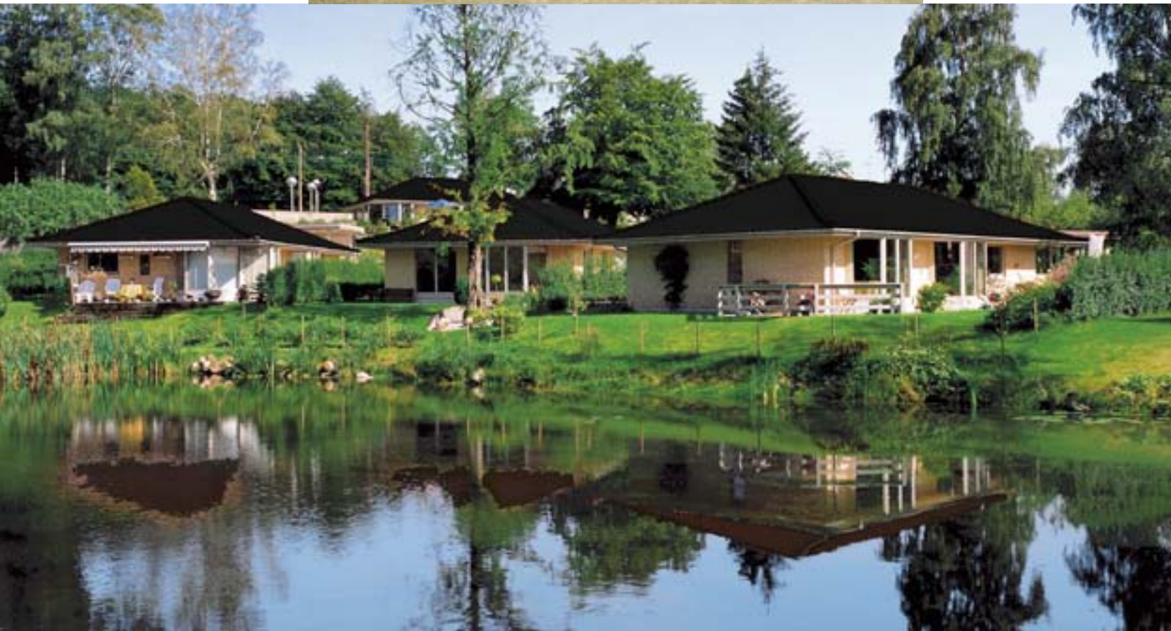
Læggehuse fra DesignSerien opført i valmhusarkitektur.
