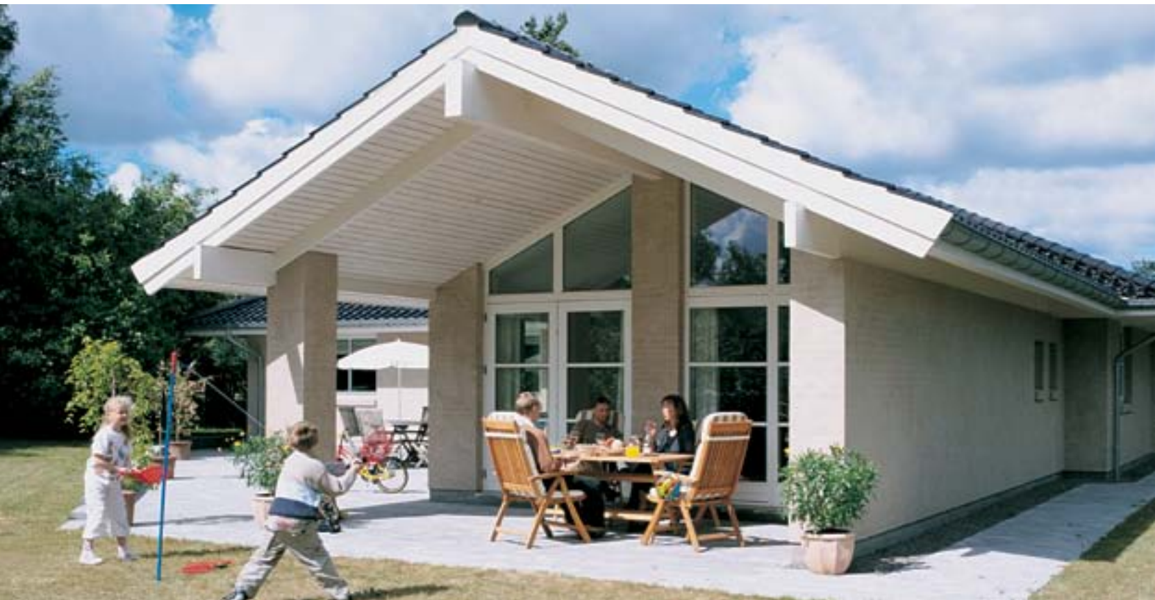
Overdækket terrasse på vinkelhus opført i rustikhusarkitektur.
