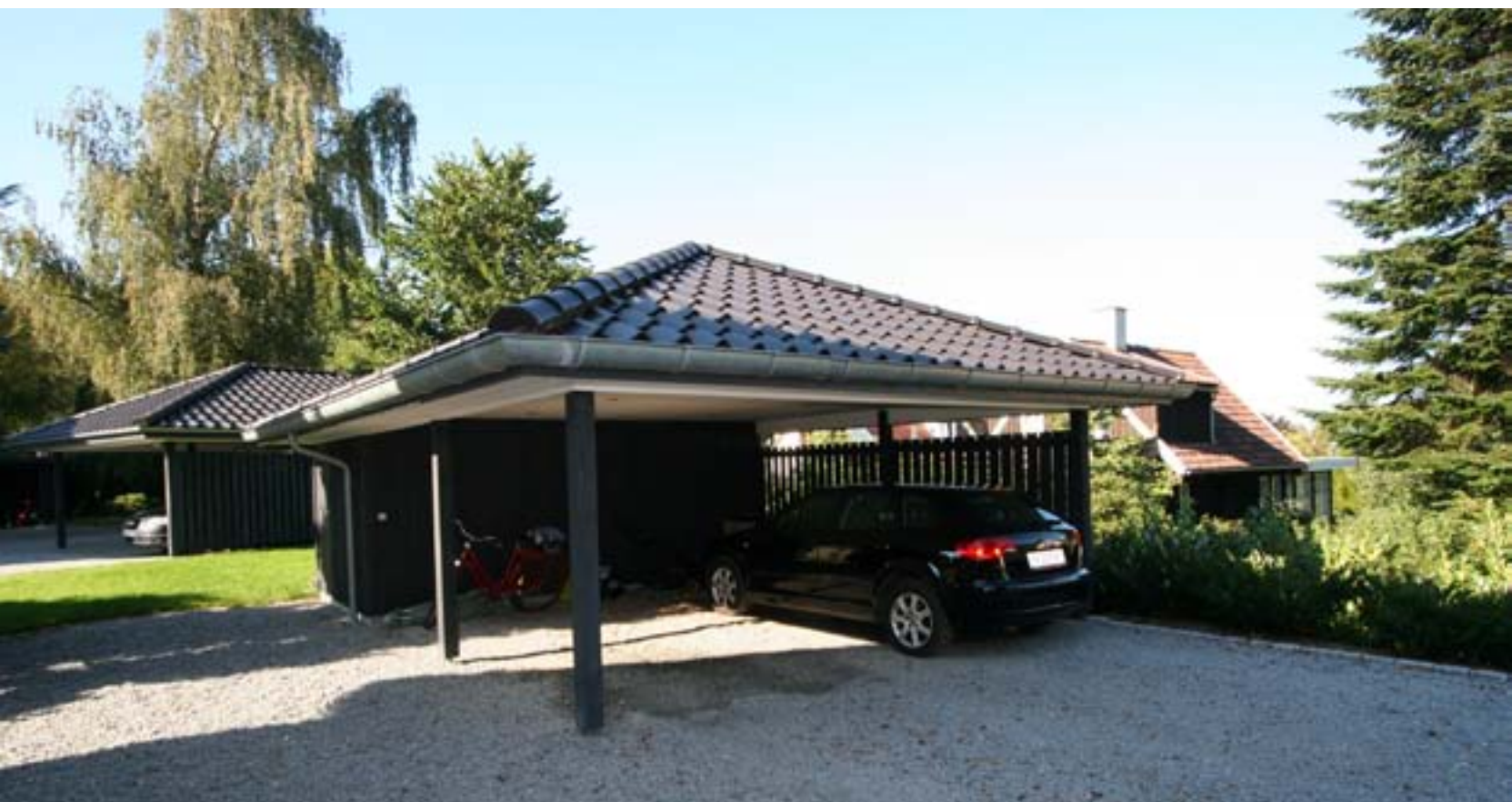
Dobbelt fritliggende carport opført i valmhusarkitektur, med redskabsrum og læhegn
