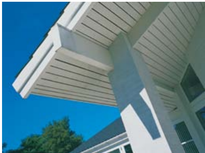
Detaljefoto fra overdækket terrasse, her vist med muret søjle.
