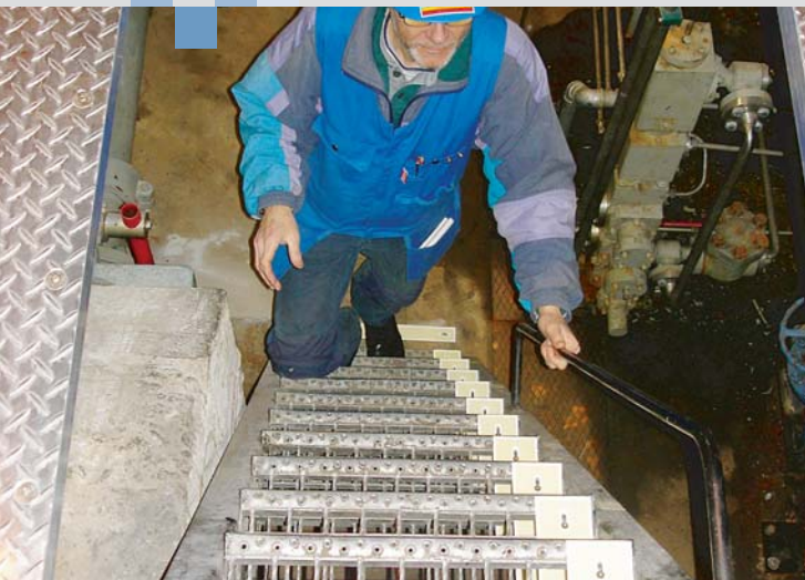
Everglow Star1 - 200x80 mm monterad i en gallerdukstrappa.
