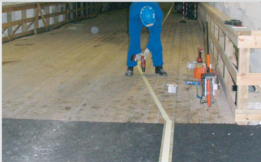
Everglow Star 1 - 1000x50 och 500 x 50 mm, monterad på en 45x95mm tryckimpregnerad bräda, som en vägledande linje i en kraftverkstunnel.
